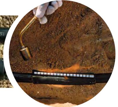
Las mangas de cierre 3M garantizan la protección de derivaciones en baja tensión.
